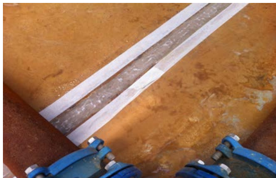
Remplissage du joint et masquage
