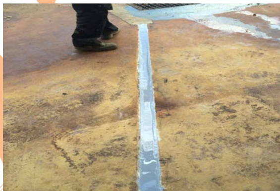
Joint en cours de polymérisation
