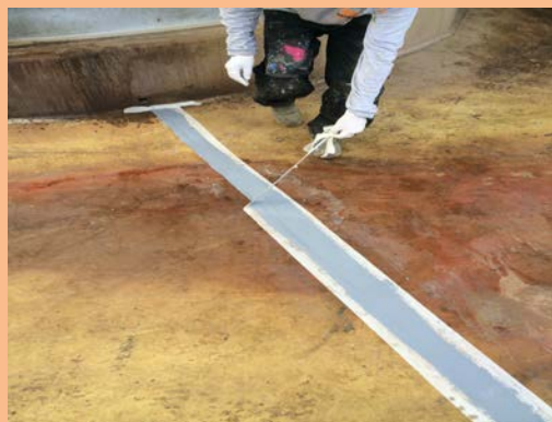
Dépose des protections
