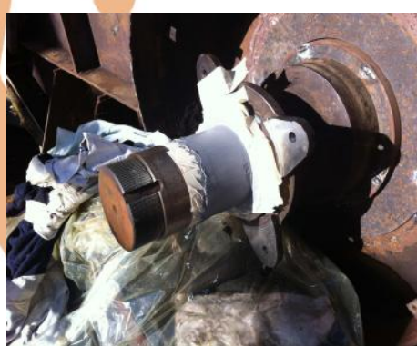
Rechargement au Belzona 1111
