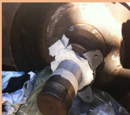
Protection et dégraissage
