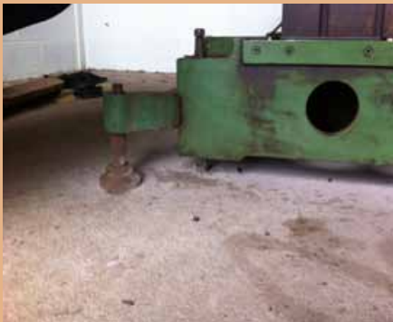
Scellement des tiges filetées.
