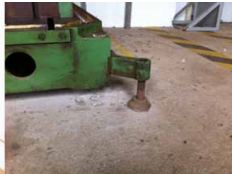
Perçage de la dalle pour scellement.
