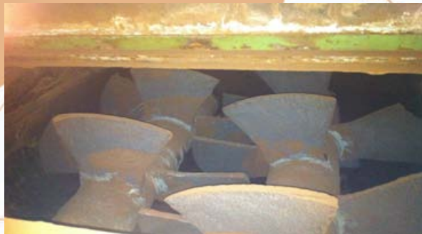
Application d'un polymère résistant à l'abrasion, le BELZONA 1812
