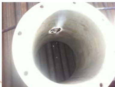
Intérieur à traiter.
