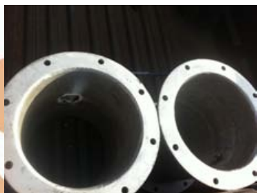
Manchettes avant travaux.
