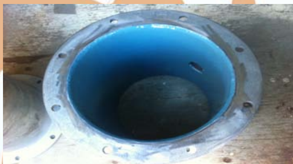
Après sablage application de deux couches de BELZONA 1341 SUPER METAL GLIDE.
