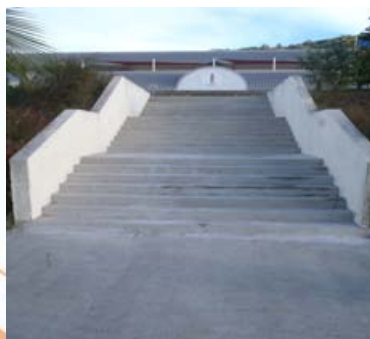
Escalier d'accès après
