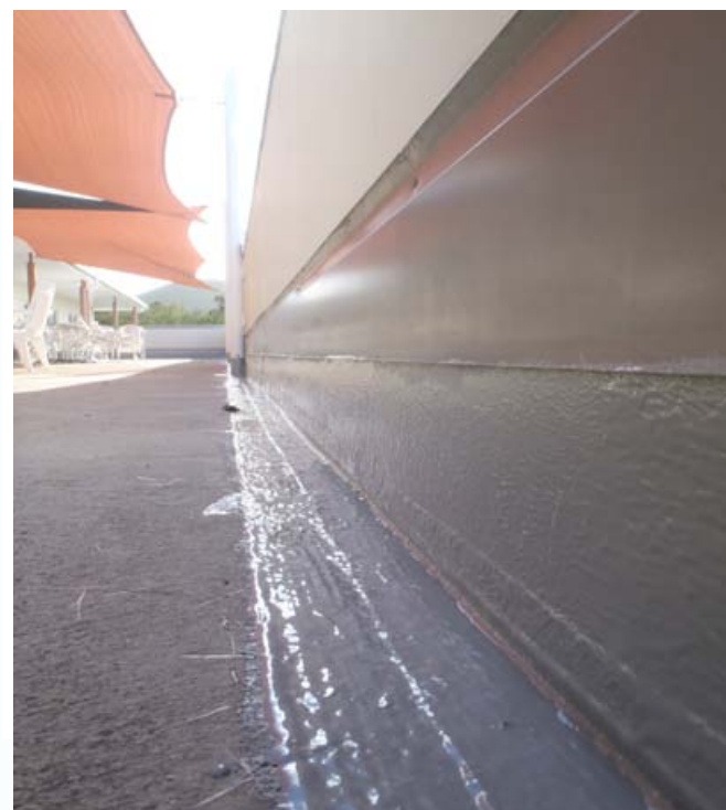
Etanchéité en fibre et résine
