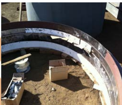
Préparation de surface et mise en place des premiers.
