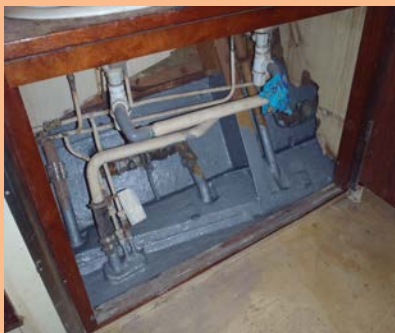
Etanchéité par fibre et résine époxy
