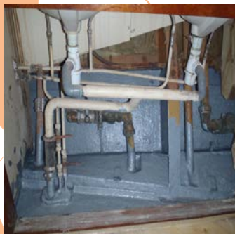
Etanchéité par fibre et résine époxy
