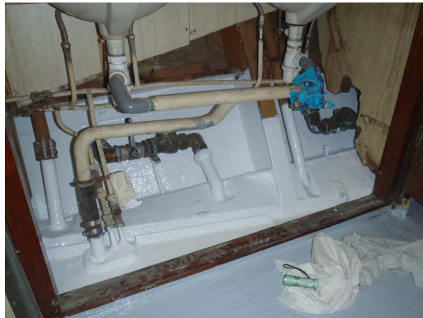
Etanchéité en fibre et résine et application d'une finition polyuréthane
