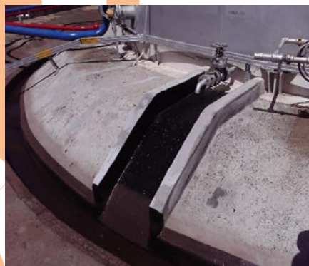
2 couches de Belzona 5811
