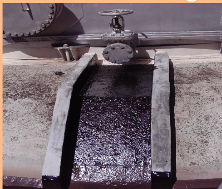
Caniveau de bac en Belzona 5811
