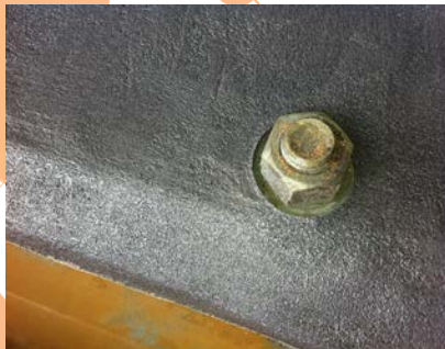
Camouflage de la boulonnerie pour le démontage de la lame.
