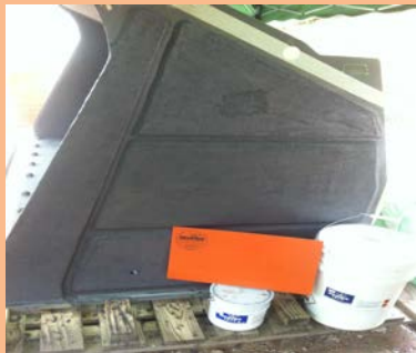
Application d'un revêtement anti-usure de chez BELZONA.
