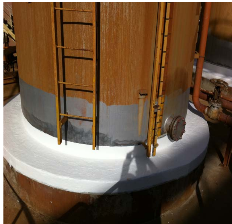
Travaux d'étanchéité en Belzona 3111 blanc
