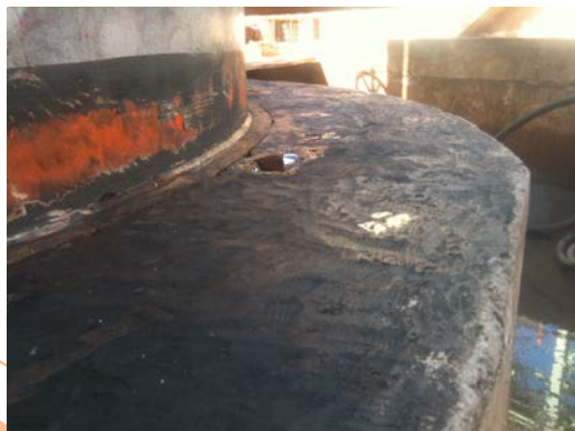
Etat de surface après lavage
