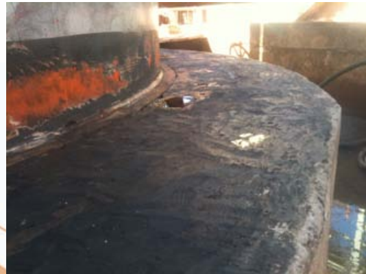
Etat de surface après lavage
