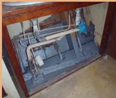
Etanchéité par fibre et résine époxy
