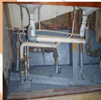
Etanchéité par fibre et résine époxy
