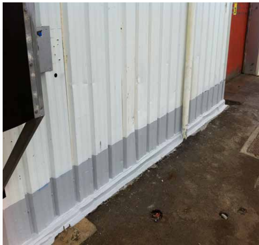
Revêtement d'étanchéité terminé
