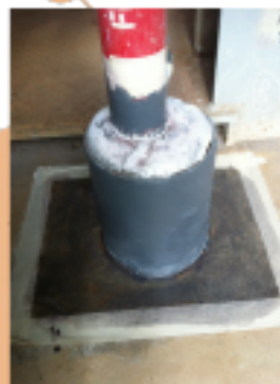
Application des primaires d'assemblages
