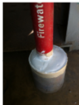
Insertion du support d'étanchéité
