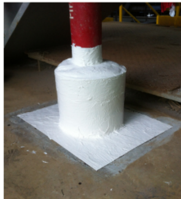
Application terminée Flexible Membrane en BELZONA 3111
