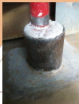
Préparation des surfaces pour l'assemblage
