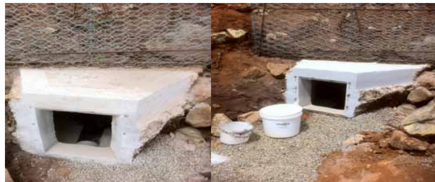
Préparation de surface et revêtement étanchéité Belzona 3111 flexi membrane
